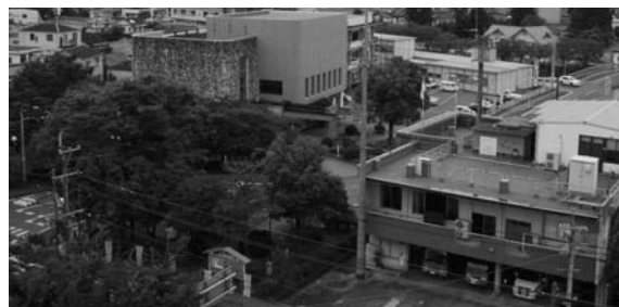
庁舎建設予定地
