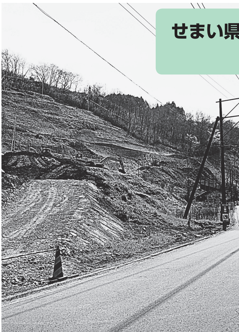
急ピッチですすむ矢田バイパス（大野町沈墮の滝付近）
