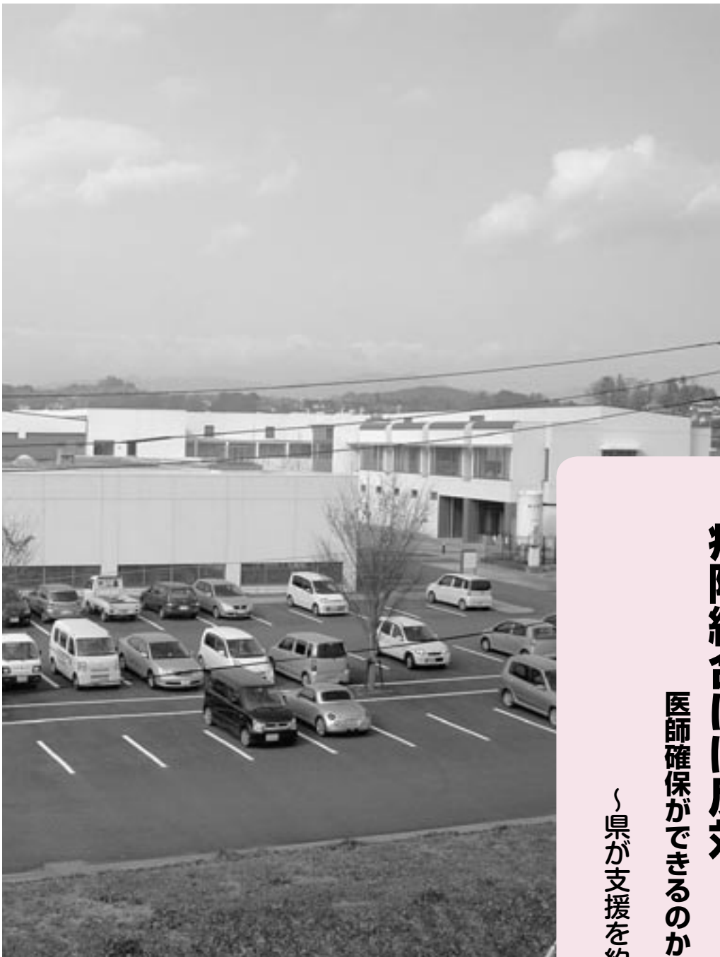
駐車場の一角が増床の予定地です（公立おがた総合病院）
