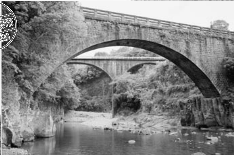
出合橋（手前）と轟橋（奥）
