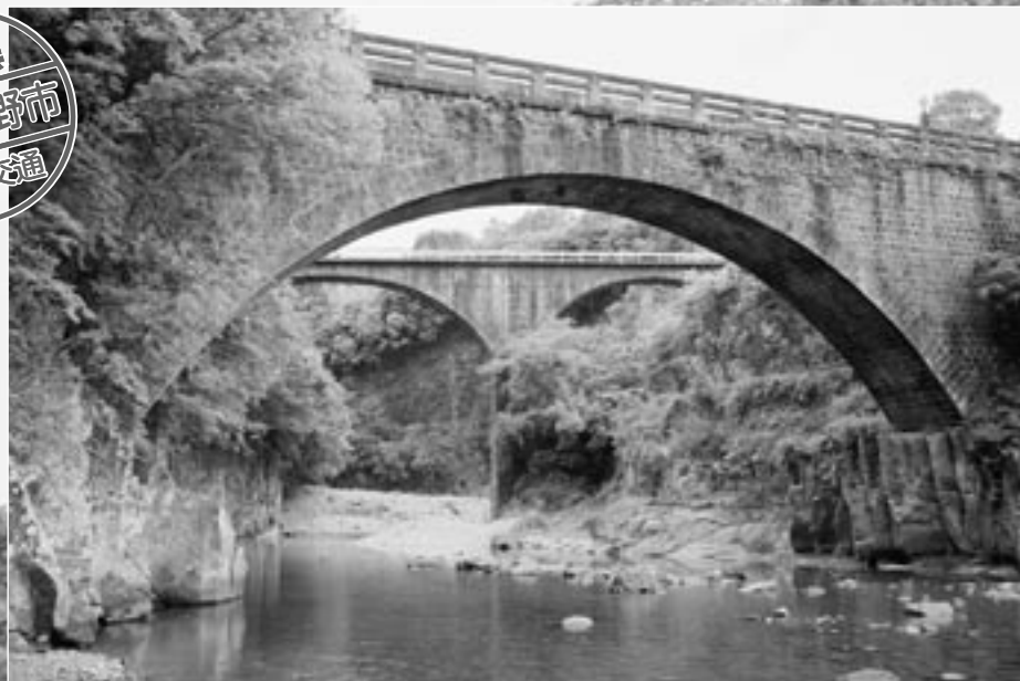
出合橋（手前）と轟橋（奥）
