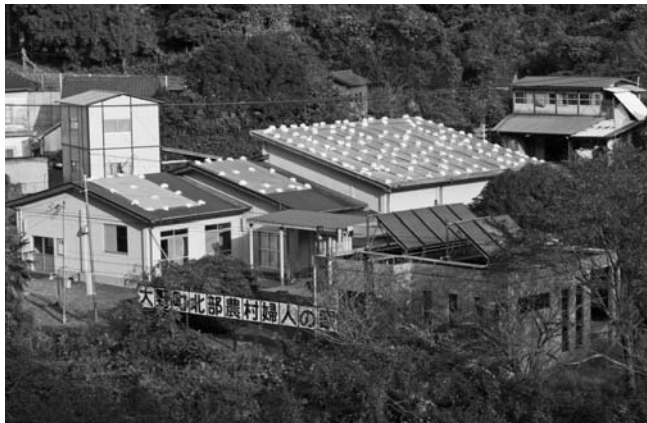
▲ ビニールシートの上に土のうを積んだ施設（大野町）
