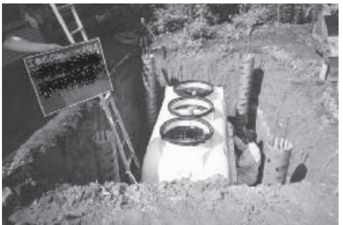
▲施工中の合併浄化槽
