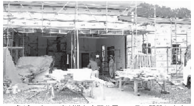
▲急ピッチで工事が進む大野分署…4月に開設します
