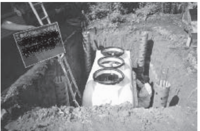
▲施工中の合併浄化槽
