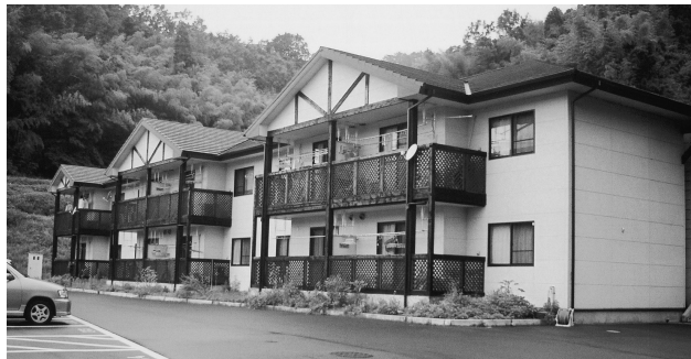
▲オール電化の市営石田団地（朝地町）
