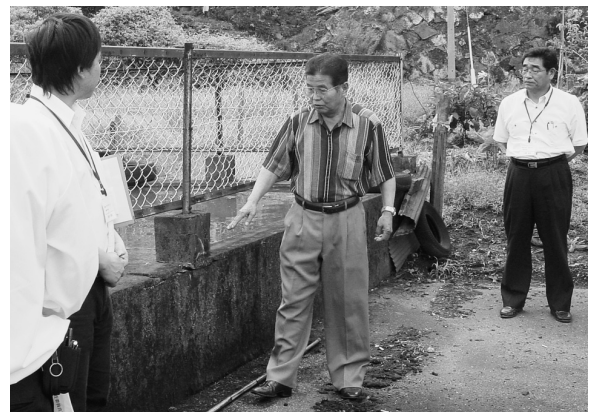
老化の進んだ防火水槽（清川町砂田）
