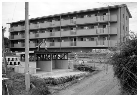
間もなく完成の久原(犬飼町)住宅
