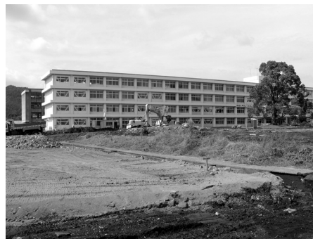
来々年4月開校の新設高校建設現場 (三重農業高校東側)
