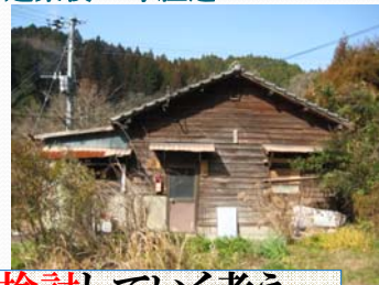
市営大恩寺住宅(朝地町) 建築後57年経過
