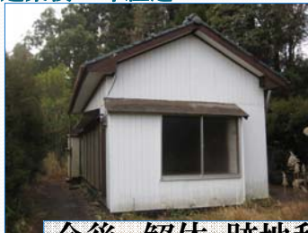
市営六種住宅(清川町) 建築後64年経過
