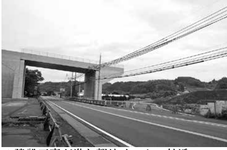
▲建設工事が進む朝地インター付近
