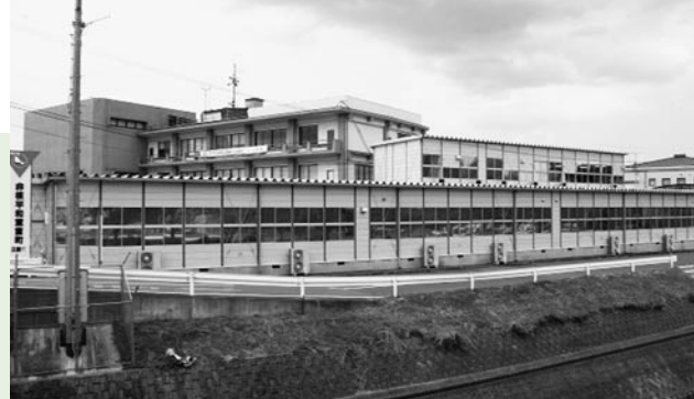
▲仮設の第2庁舎
