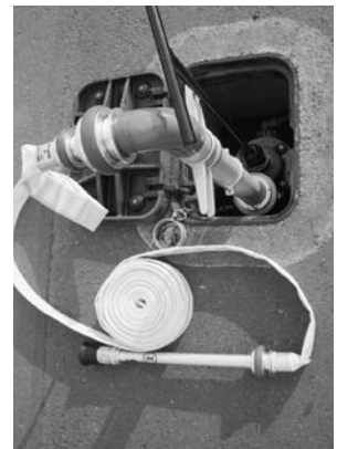
▲消火栓に簡易消火用具を接続したものの
