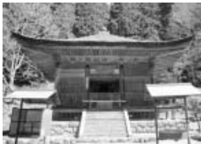
▲改修前の神角寺本堂
