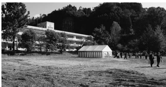
▲西部給食調理場が建設される旧大恩寺小学校グラウンド
