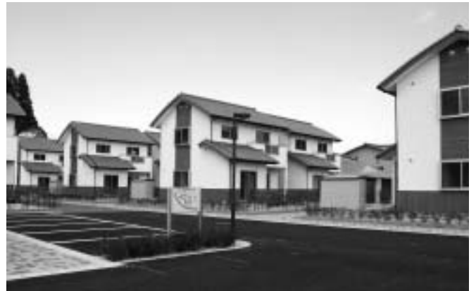
▲快適で良質な魅力ある住宅を整備します
