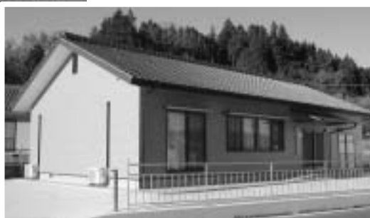
▲待望のうえ完成した羽飛区コミュニティセンター
