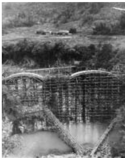
▲建設中の轟橋(手前)と出會橋(奥)(清川町)
