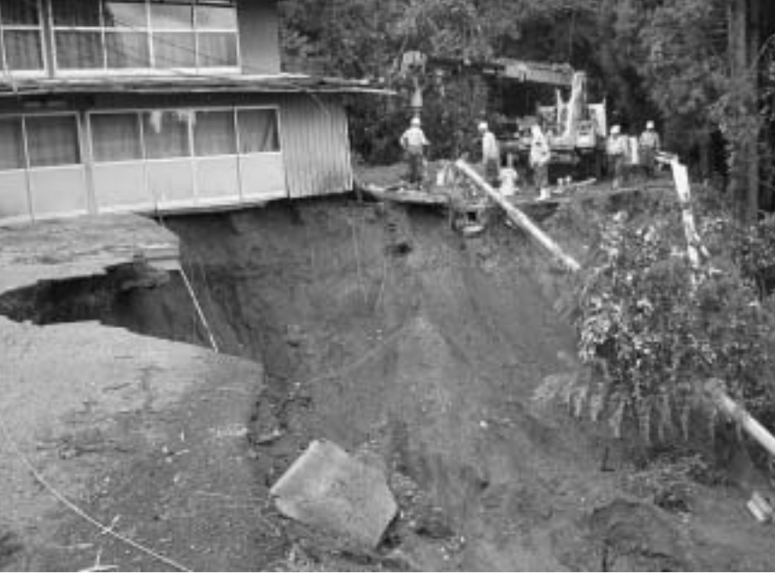
▲道路が崩落した緒方町上畑
