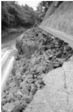
▲生活道も崩落(清川)
