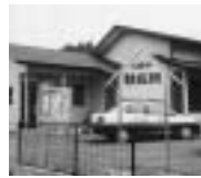
大野町駐在所 (団地内)
