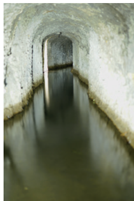
凝灰岩の井路トンネル
