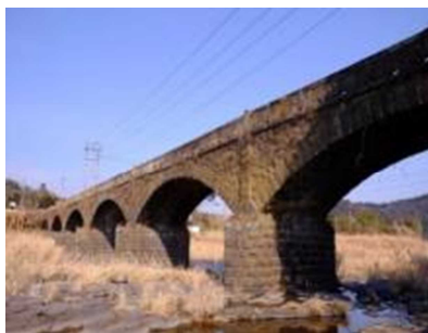
写真 19 長瀬橋（大正 12 年建設）
