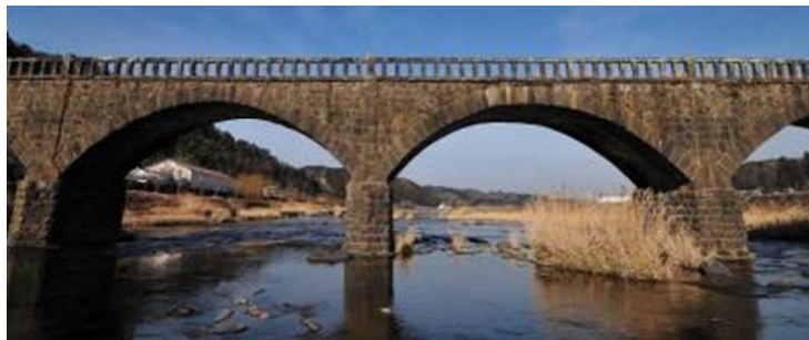
写真 20 原尻橋（大正 12 年建設）
