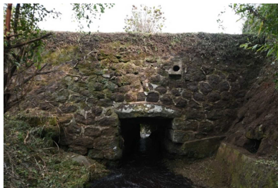
写真 39 黒土甲川架樋の隧道入口
