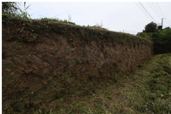
写真 38 黒土甲川架樋の側面石垣
