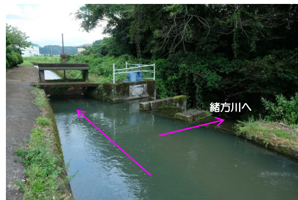
写真 49 鉢ノ久保放水門
