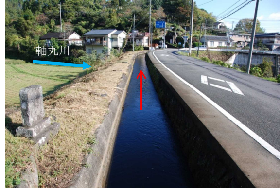
写真 47 高石垣を流れる上井路
