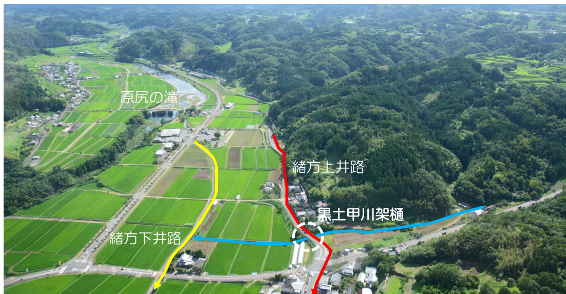
写真 37 黒土甲川架樋の位置
