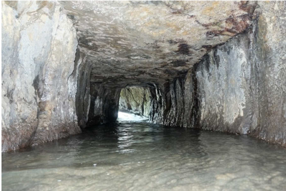
写真 46 高石垣下の隧道
