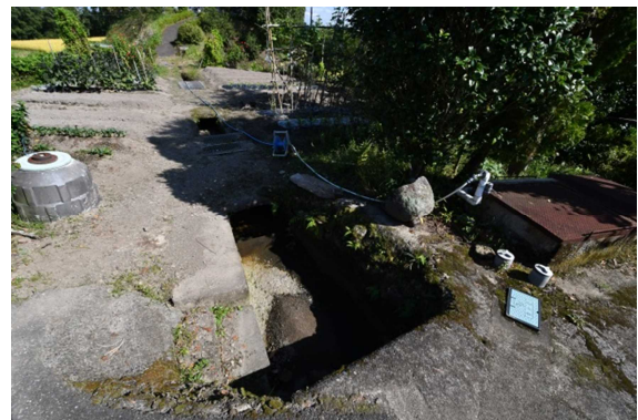
写真 29 室屋小林線にある汲ん場
