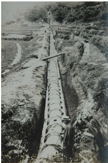
写真 25 富士緒井路のサイフォン敷設
