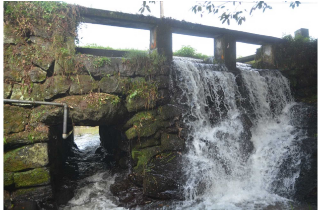
写真20 石用川を越す石樋
