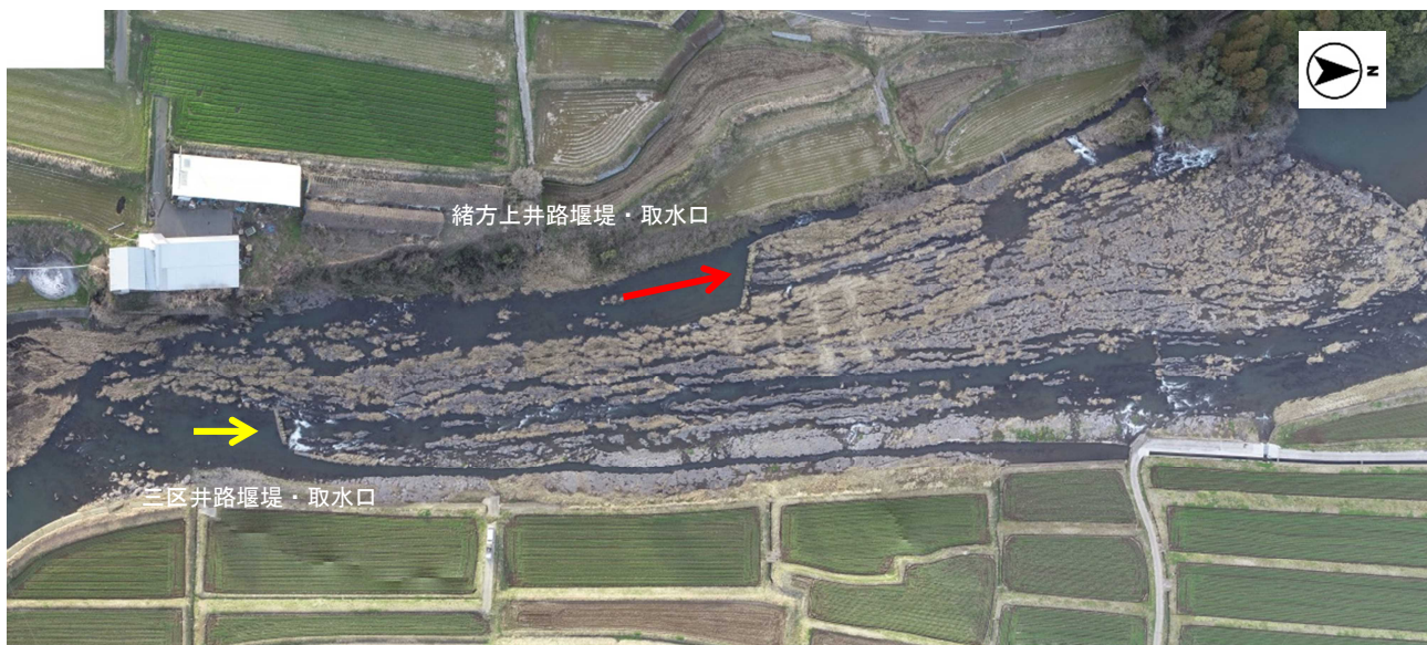
写真 14 緒方上井路と三区井路（野仲井路）の堰堤・取水口
