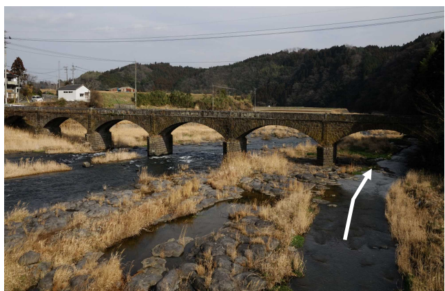
写真7 長瀬橋と原尻古井路の取水口
