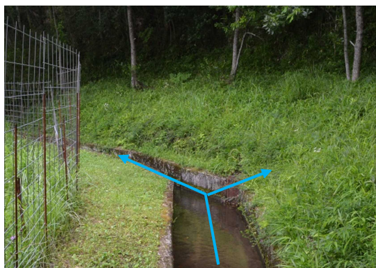
写真 117 原尻新井路と宮迫支線分岐点（原尻側）
