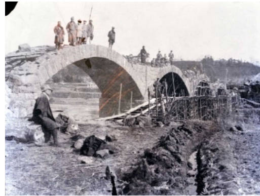
写真110 建設中の原尻橋
