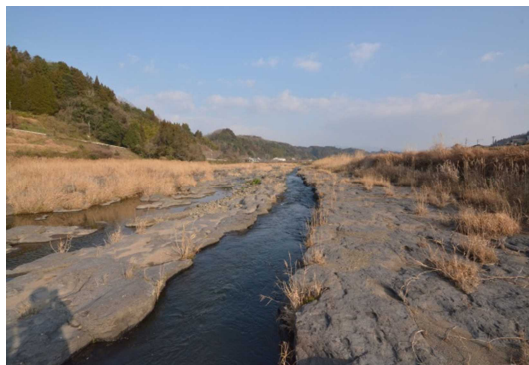
写真 103 三区井路の掘り割り
