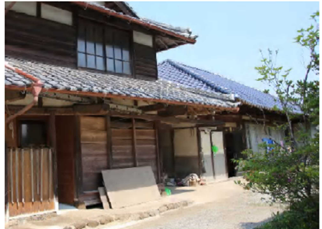
写真 39 農家住宅のプロトタイプ (後藤家住宅) 主屋は直屋 (すごや) で「オトシゴンヤ (落とし小屋)」が、並置屋根は、茅葺を寄棟瓦葺きに改修している。
