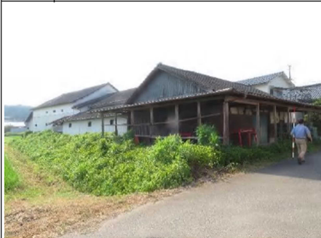
写真番号 003 撮影日 20180725 外観(南西面)
