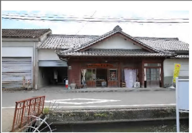
写真番号 004 撮影日 20180809 外観(北面)
