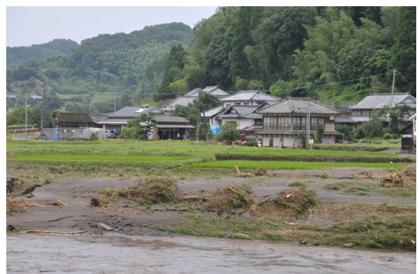
写真 18 冠水した圃場と住宅（下自在志賀）
