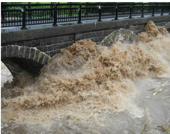
写真11 鳴滝橋 (馬場～知田間)
