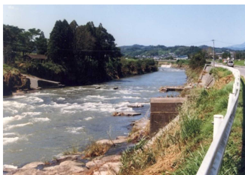
写真 3 流失した東仙寺橋
