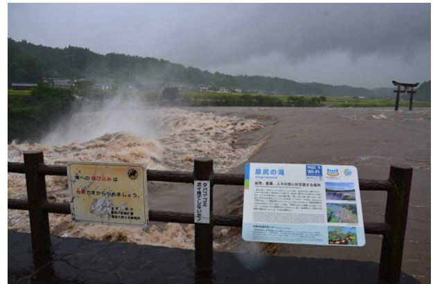
写真 30 原尻の滝と水没した道路
