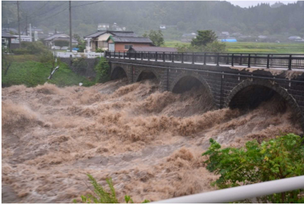
写真 27 緒方川と鳴滝橋（下流から）
