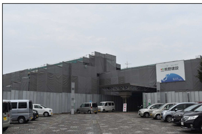
▲改修中の大原総合体育館（玄関）
