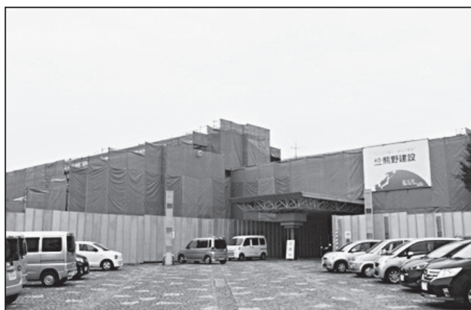
▲改修中の大原総合体育館（玄関）
