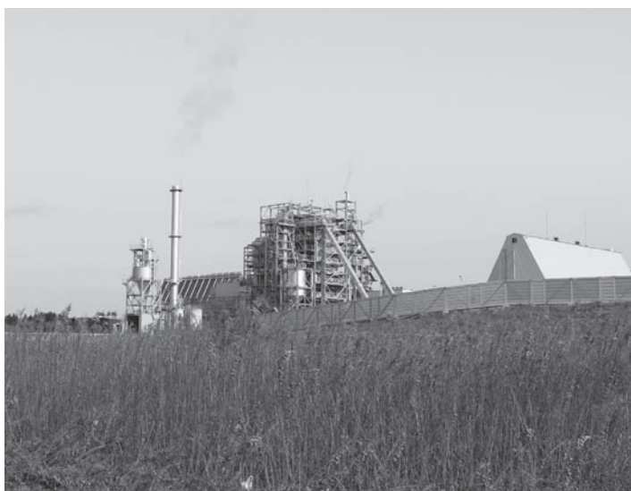
木質バイオマス発電所
