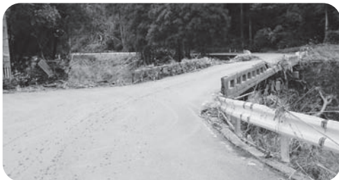
三重町白山地区県道
