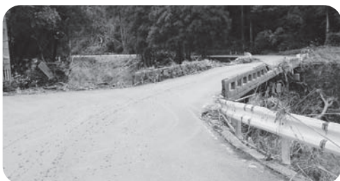
三重町白山地区県道
