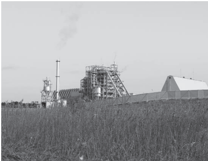
木質バイオマス発電所
