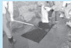
農道の部分補修
