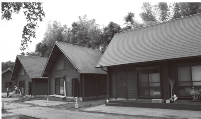
改修工事が進む井崎河川公園
