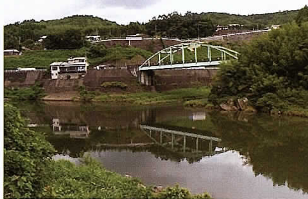
吐合港付近遠景
