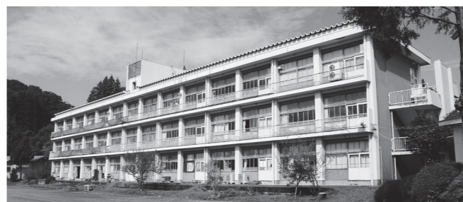
現清川中学校校舎
