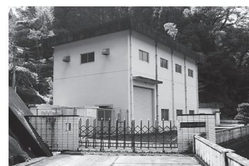
農業用水を利用した 富士緒井路第二発電所(緒方町)
