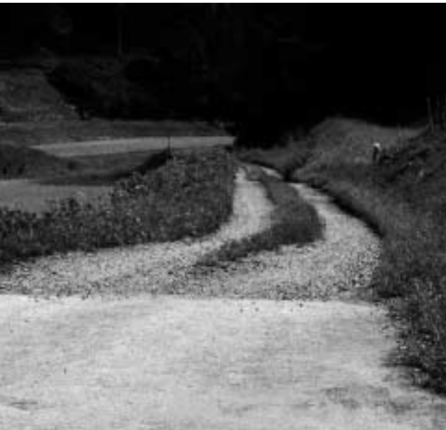
未舗装の市道（大野町）
